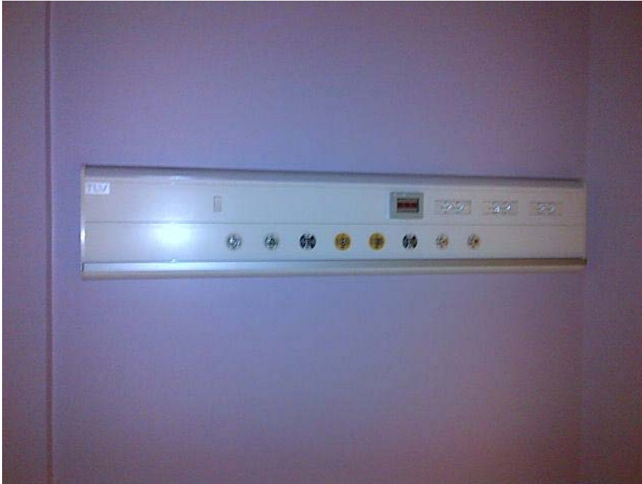
FIG. 15 PRESE DI EROGAZIONE GAS MEDICINALI A SU TRAVE TESTA LETTO
